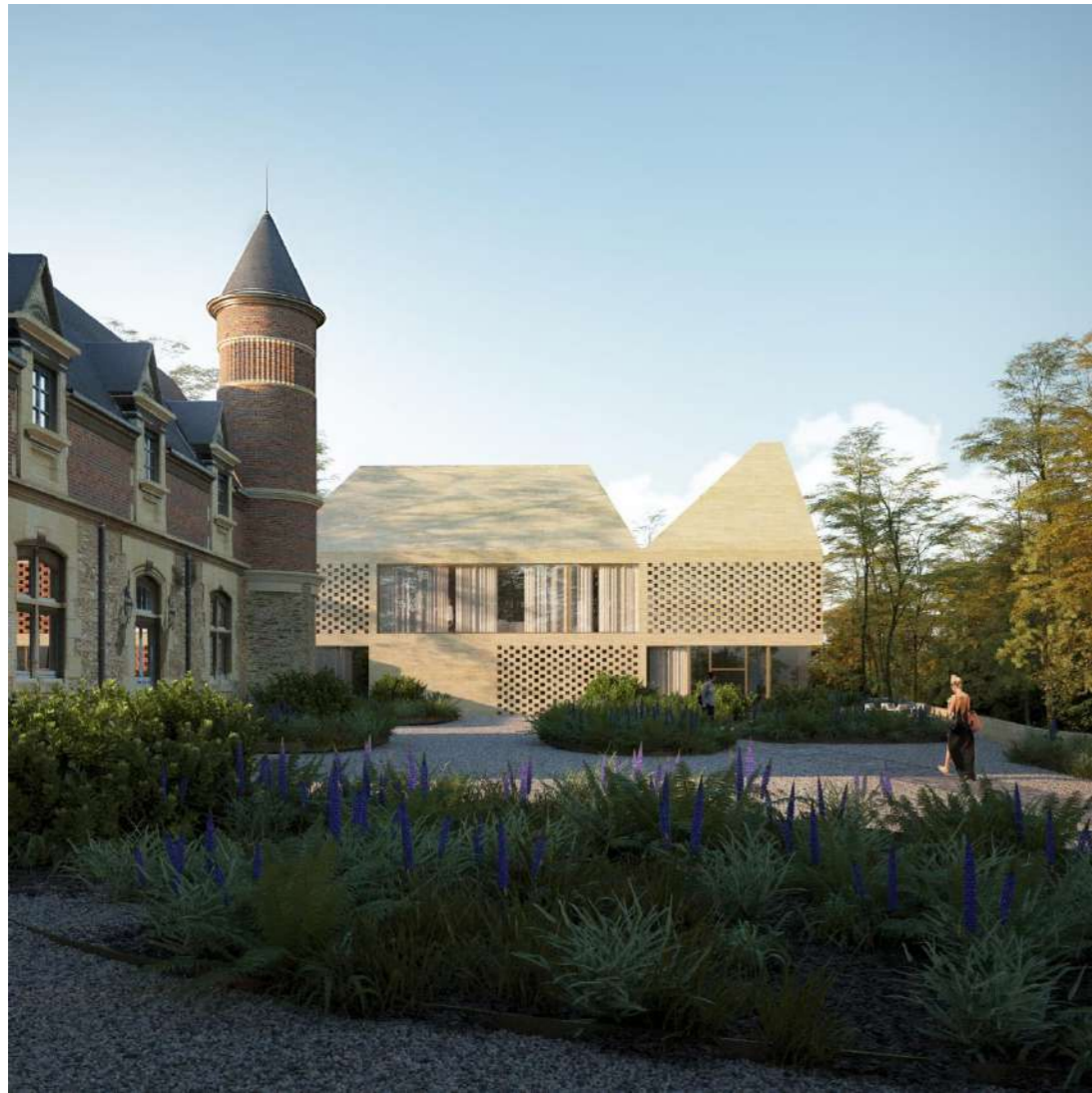
Vue du SPA depuis le château
